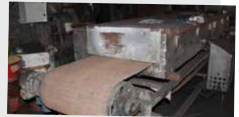
„Mit unserem elektrischen Ofen können wir Zeit und Temperatur der Wärmebehandlung genau kontrollieren“, so Alberto. Diese beeinflusst die Molekular-Struktur (und damit Haltbarkeit) der Becken.
